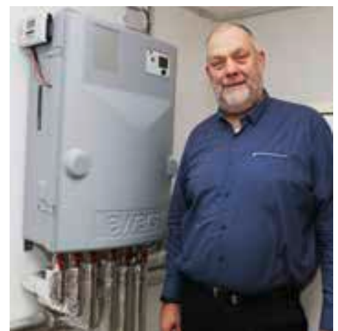
Kapitän Olaf Schulz im Keller neben der platzsparenden Wärme-Übergabestation in seinem Haus.
